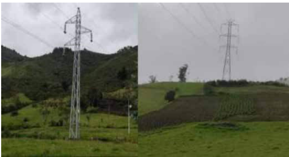
Figura 37. Sistema de Transmisión de Energía eléctrico.
