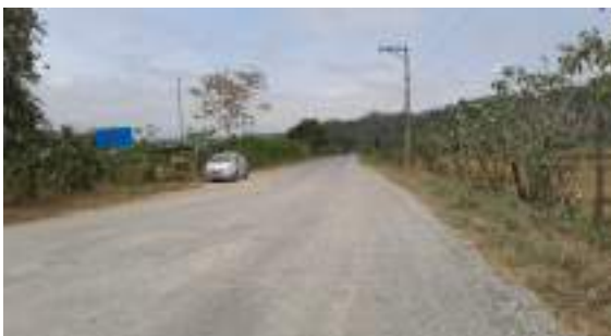
Vía Nuevo Tabete- Mutile- Las Minas
