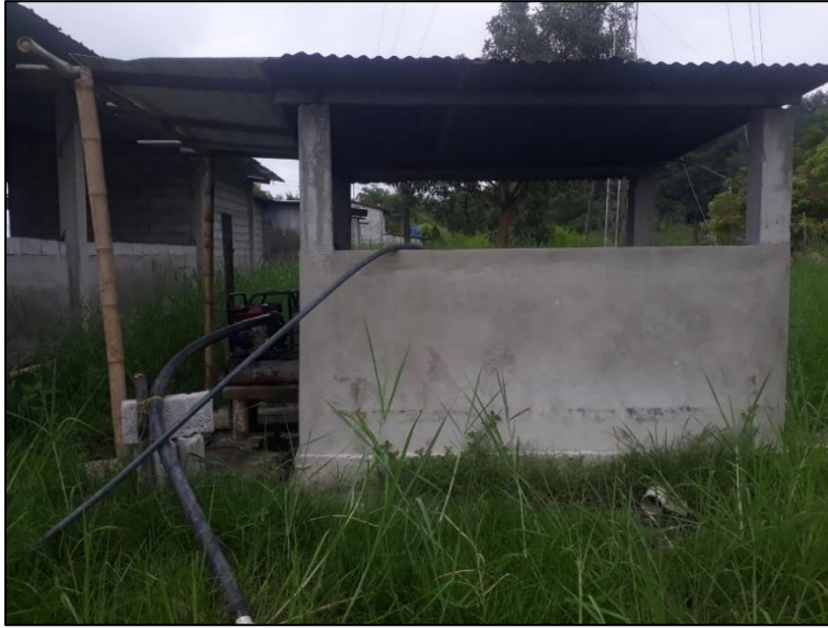
Fotografía. 4: Captación de sector de Santo Domingo
