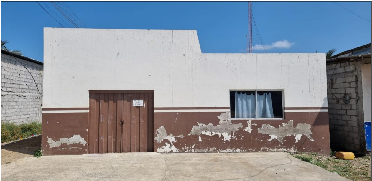
Fotografía. 10: Puesto de Salud, Puerto Roma
